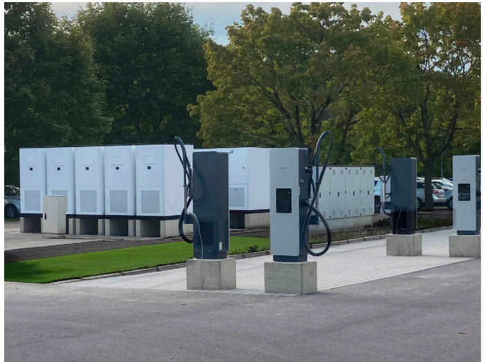
POLNILNA POSTAJA ZA E-VOZILA S HRANILNIKOM G-MAX NA ISTI LOKACIJI
